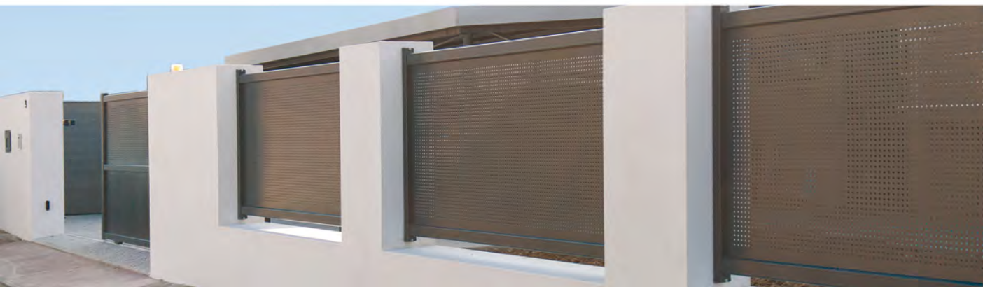
Portail coulissant et clôtures Argelès
