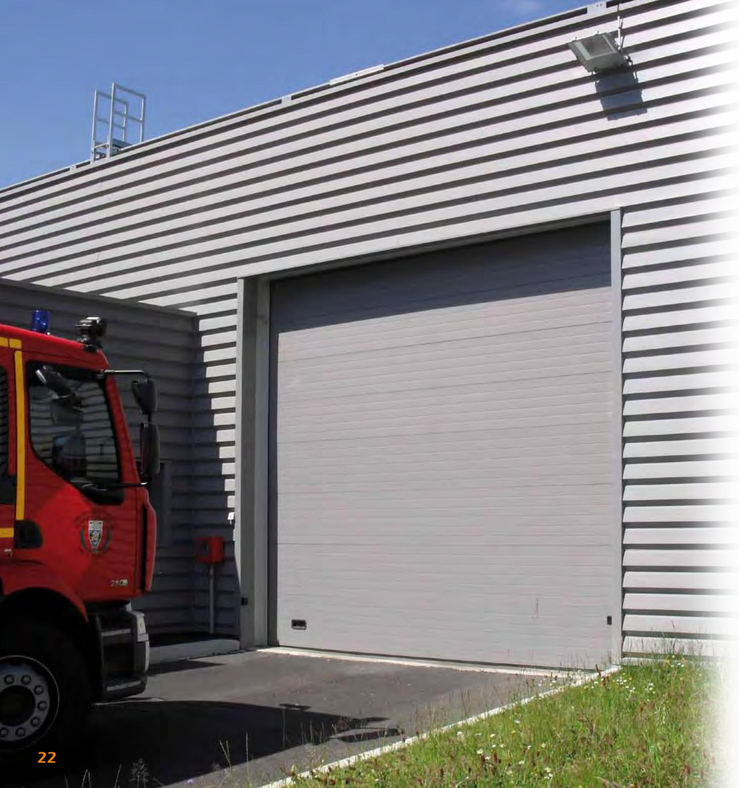
Conçue « sur-mesure » pour la fermeture des ateliers ou locaux industriels, la porte sectionnelle Industrie s'adapte à tous types d'architectures (levée normale, en pente, haute ou verticale). Esthétique et sûre, cette porte assure le clos de votre bâtiment.
